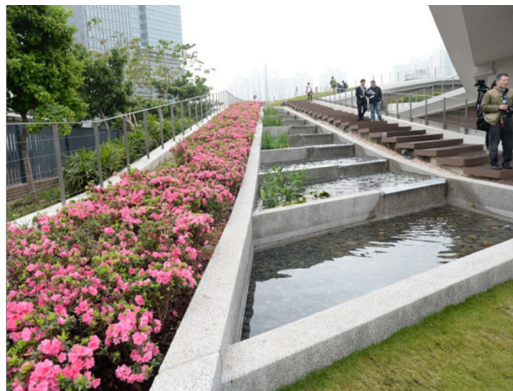
圖 32 九龍城一號污水泵房(綠建環評鉑金級)
